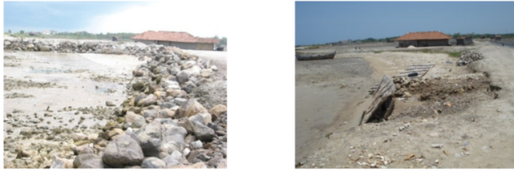
Gambar 5. Kenampakan abrasi pantai di sebelah timur PLTGU Rembang, terlihat bibir pantai cekung. Kanan : kondisi saat ini telah dibuat tumpukan batu untuk melindungi pantai, kiri : kondisi sebelum diberi perlindungan.
