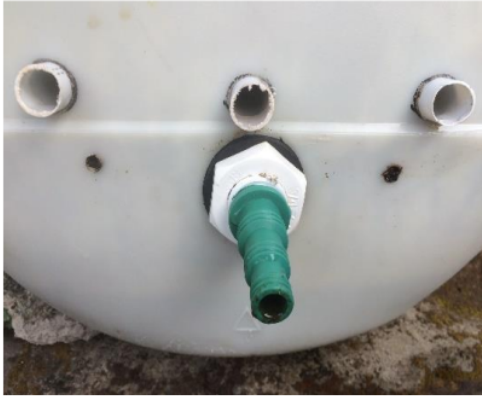
Gambar 1. Modifikasi outlet pada unit komposter
