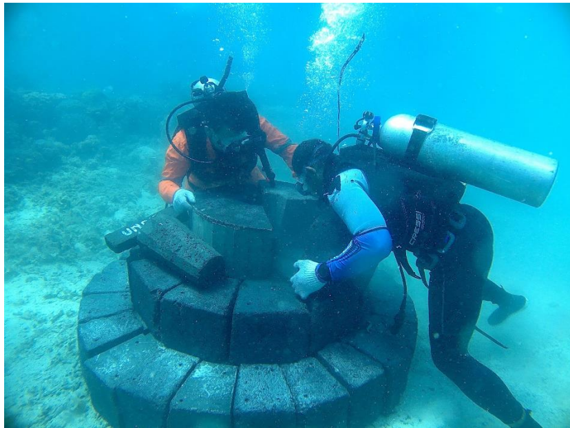
Gambar 5. Pemasangan Purwarupa APR dengan menyusun modul balok beton di lokasi rehabilitasi terumbu karang P. Cilik, Kepulauan Karimunjawa
