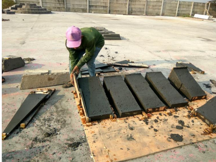
Gambar 3. Pencetakan balok beton sebagai komponen pembentuk APR berbahan baku Bottom Ash
