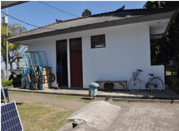
Gambar 21. Toilet di PPN Pengambengan
