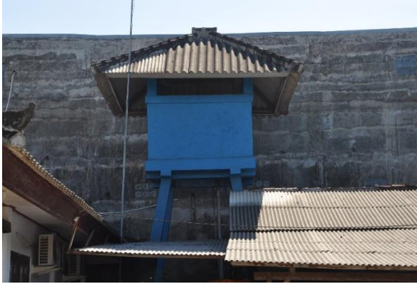
Gambar 10. Tower Air di PPN Pengambangan
