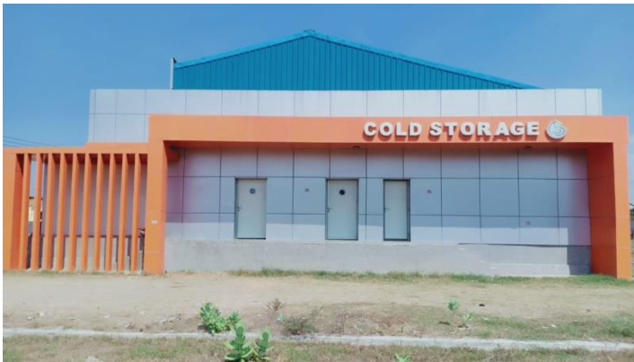
Gambar 12. Cold Storage di PPN Pengambangan
