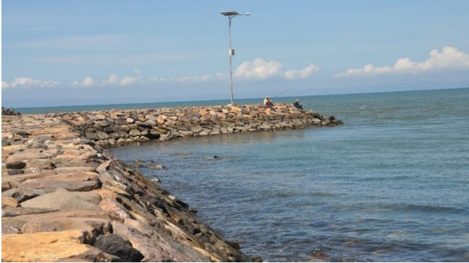
Gambar 5. Breakwater di PPN Pengambangan
