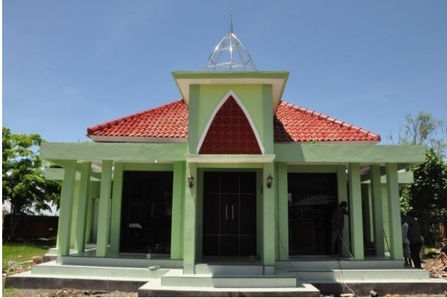
Gambar 20. Mushola di PPN Pengambengan
