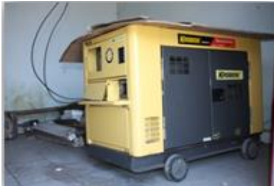
Gambar 14. Genset PPN Pengambangan
