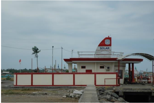
Gambar 13. SPBN di PPN Pengambangan
