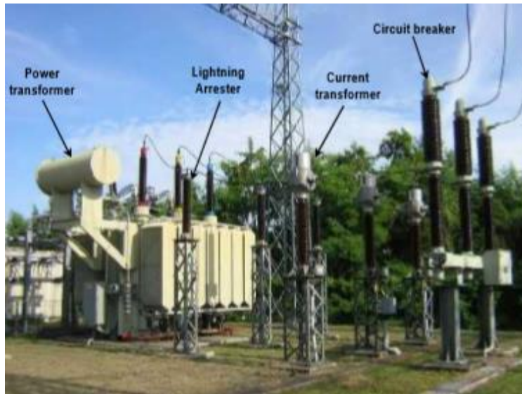
Gambar 25 Contoh Peralatan Gardu Induk
