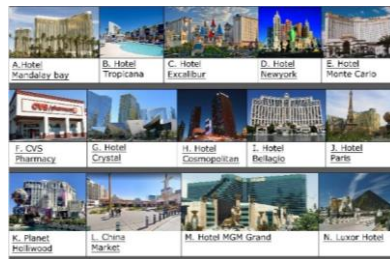
Gambar 2. Karakteristik Bentuk Bangunan pada Obyek Kajian Sumber : Analisa Pribadi, 2020
