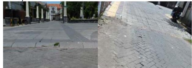
**Gambar 10.** Kondisi Paving di Jl Garuda dan Jl Branjangan
