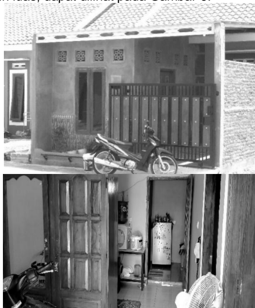
Gambar 6. Kondisi Ruang Rumah R-2 Sumber: Dokumentasi Penulis, 2020
