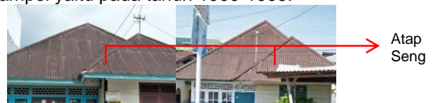
Gambar 3. Bahan atap pada rumah vernakular di Kampung Bandar (Hasil Analisis, 2019)
