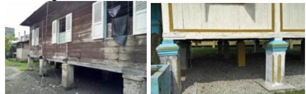
Gambar 7. Bahan pondasi pada rumah vernakular di Kampung Bandar (Hasil Analisis, 2019)
