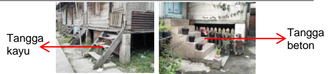
Gambar 6. Bahan tangga pada rumah vernakular di Kampung Bandar (Hasil Analisis, 2019)
