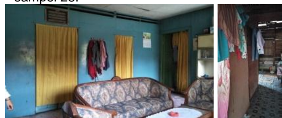
Gambar 9. Pembatas ruang material triplek (Hasil Analisis, 2019)
