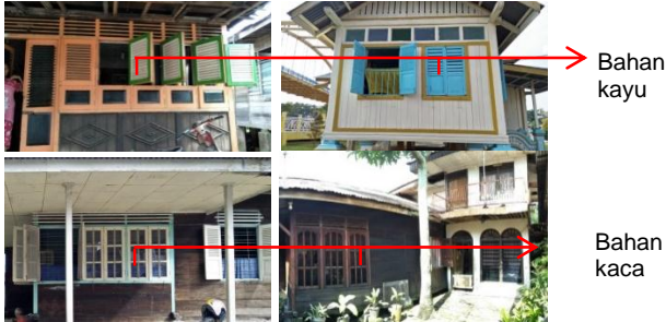
Gambar 4. Bahan jendela pada rumah vernakular di Kampung Bandar (Hasil Analisis, 2019)
