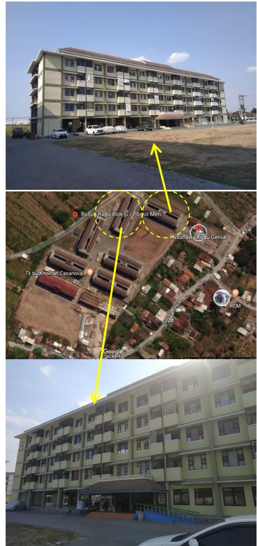
Gambar 2. Kondisi Eksisting Blok A dan B
