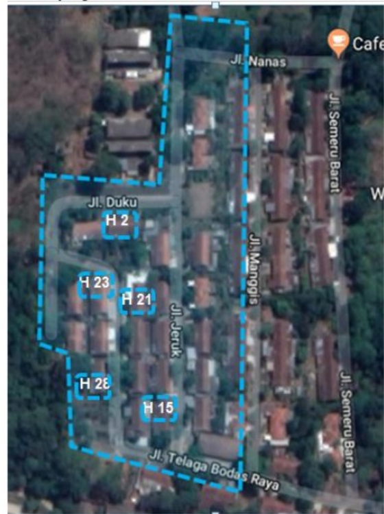
Gambar 9. Tampak atas keseluruhan Rumah Dinas Blok H.
