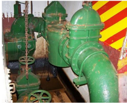
Gambar 4. Gate Valve yang dipasang pada Sea Chest [4]
