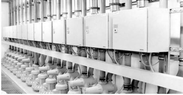
Gambar 8. *Silencer* sebagai penghubung antara blower dengan pipa utama
