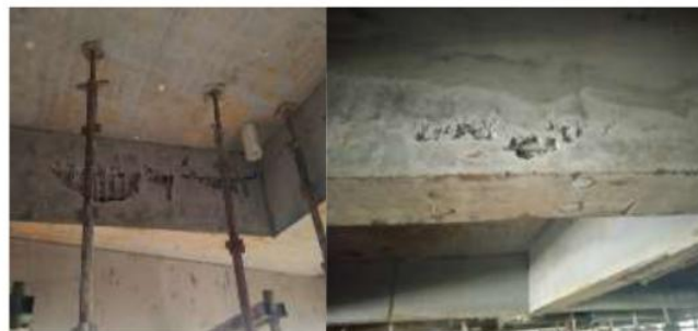
Gambar 3. Beton Keropos
