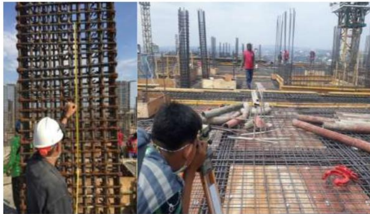
Gambar 4. Pengukuran dimensi dan marking
