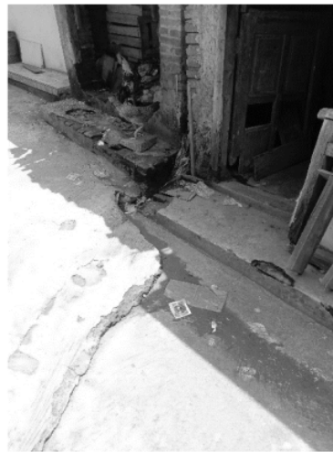
Gambar 4. Saluran air yang belum memadai
