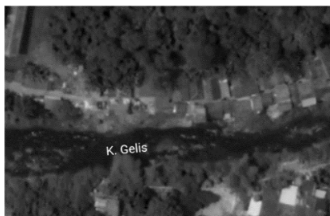
Gambar 1. Lokasi permukiman kumuh Desa Demaan
