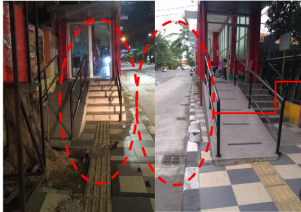
Gambar 15. Akses masuk ke Halte BRT menghalangi jalur pedestrian
