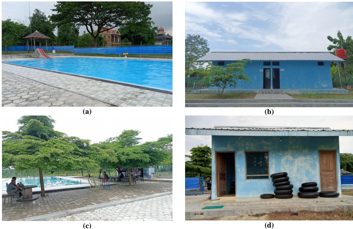
Gambar 3. Kondisi eksisting kolam renang Desa Dukuh, Kecamatan Tangen, Kabupaten Sragen (a) Area kolam renang; (b) Kamar mandi dan ruang bilas; (c) Ruang terbuka disekitar lokasi kolam; dan (d) Bangunan pengelola
